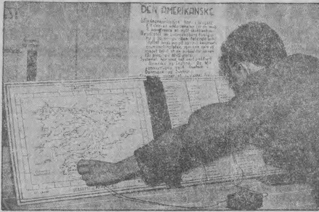
wynalazek norweskiego inżyniera, który umożliwia ślepych zapomocą elektrycznych kontaktów odczytywanie wypukłych kart geograficznych.
