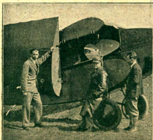
1) Awionetka polska „K.W.D. 3”. 2) Maszyna K.W.D. 3”, mająca składane skrzydła, wykonana przez studentów politechniki warszawskiej.
