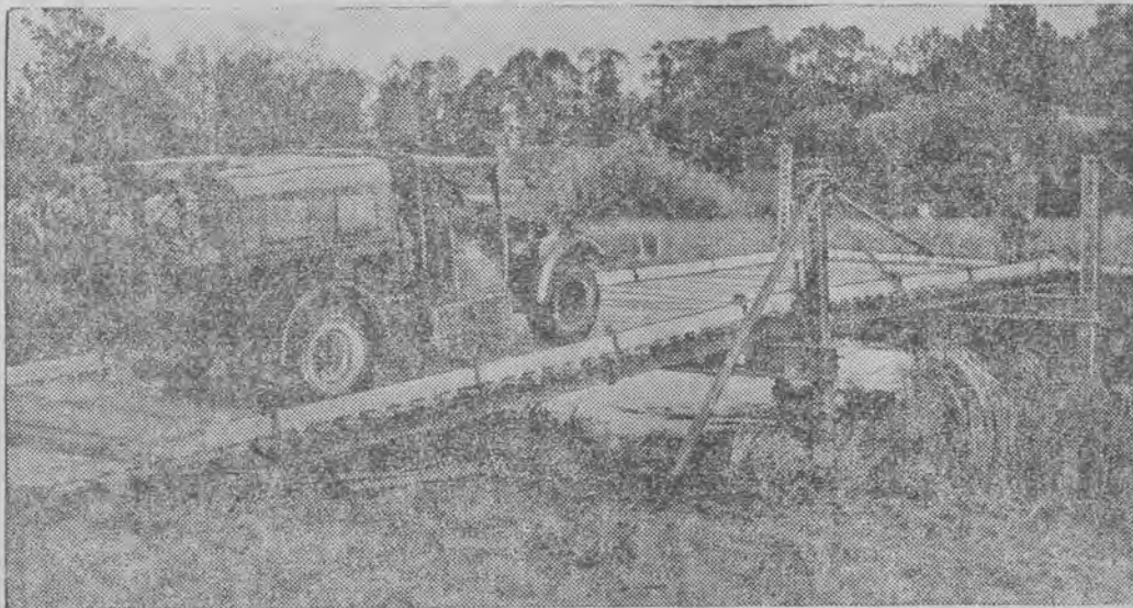
Samochody próbują zbudowany naprędcę przez pionierów most pomocniczy.
