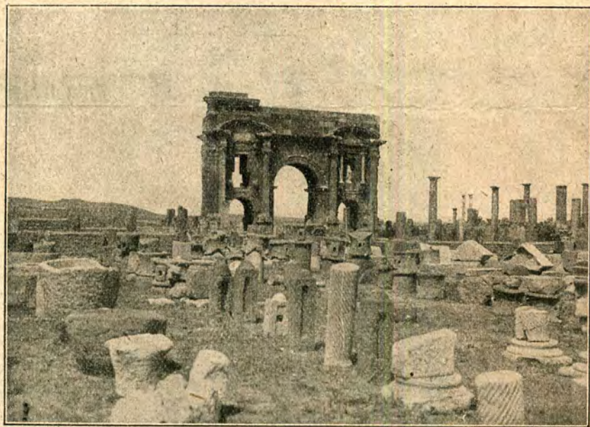
Łuk Septymiusza Sewera w Timgadzie.
