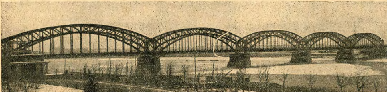
Budowa mostu kolejowego na Wiśle w Warszawie została ostatecznie ukończona.
