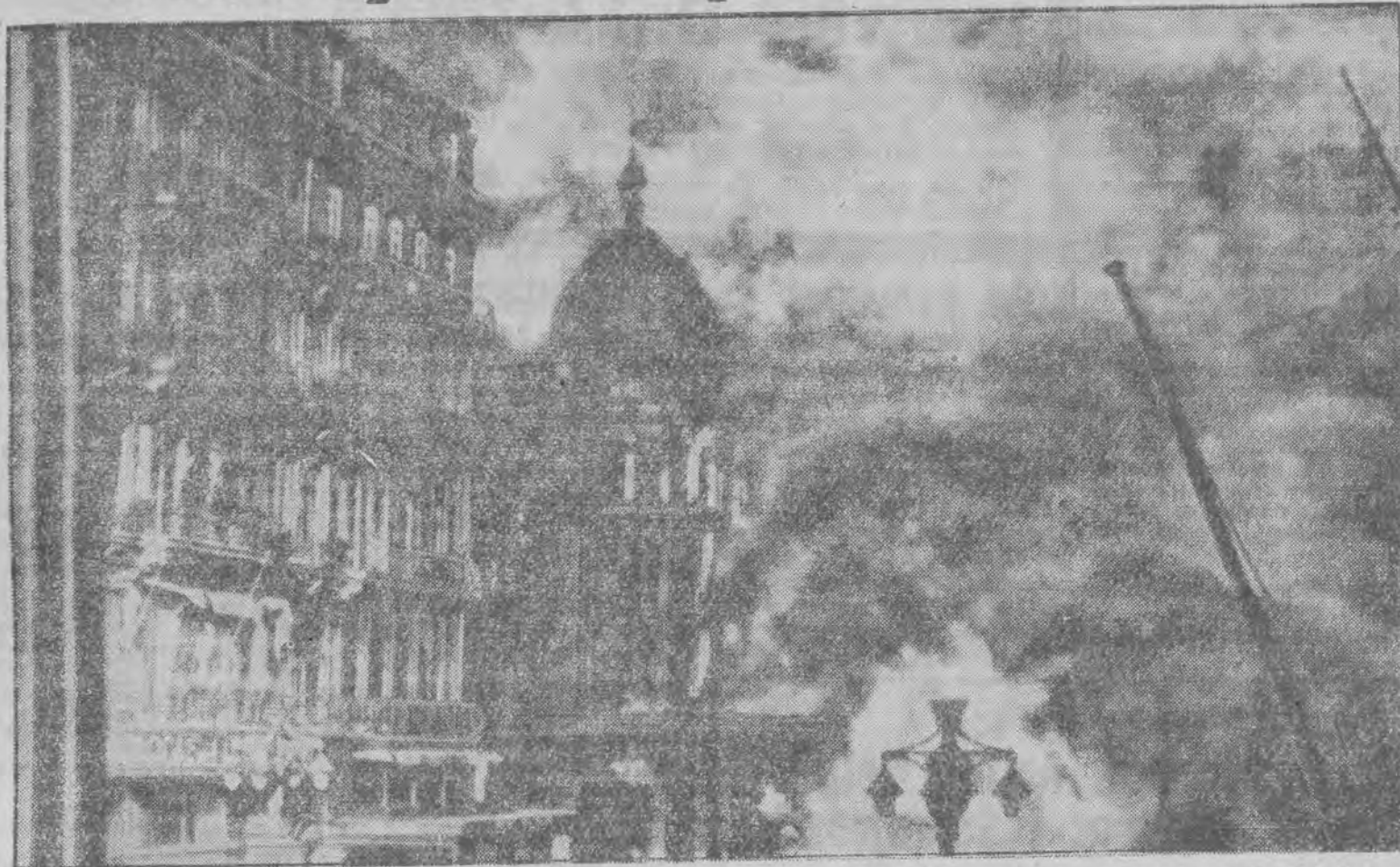
Zdjęcie domu towarowego, dokonane kilka minut po wybuchu pożaru. Obok hotel, w którym mieszkał premier Daladier.
