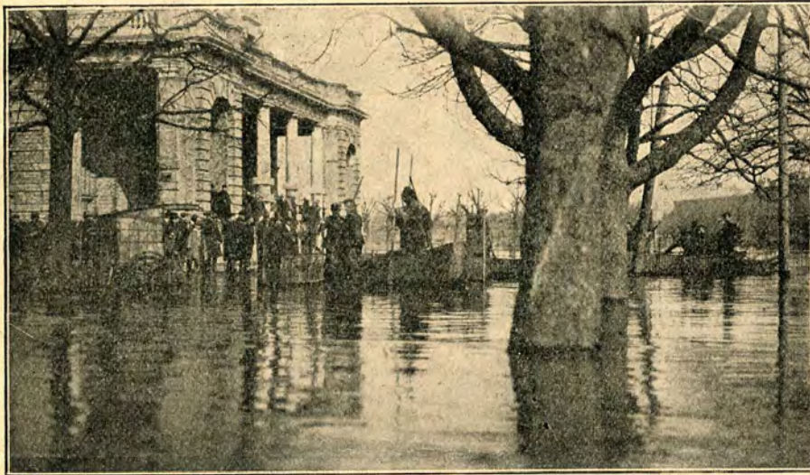
Pałac Tyszkiewiczów i część ogrodu Cielętnika znalazły się pod wodą Wilejki.
