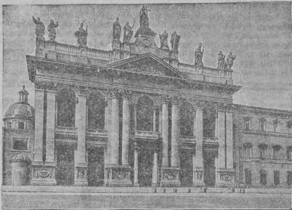
w której papież odprawi pierwszą mszę po opuszczeniu murów Watykanu,
