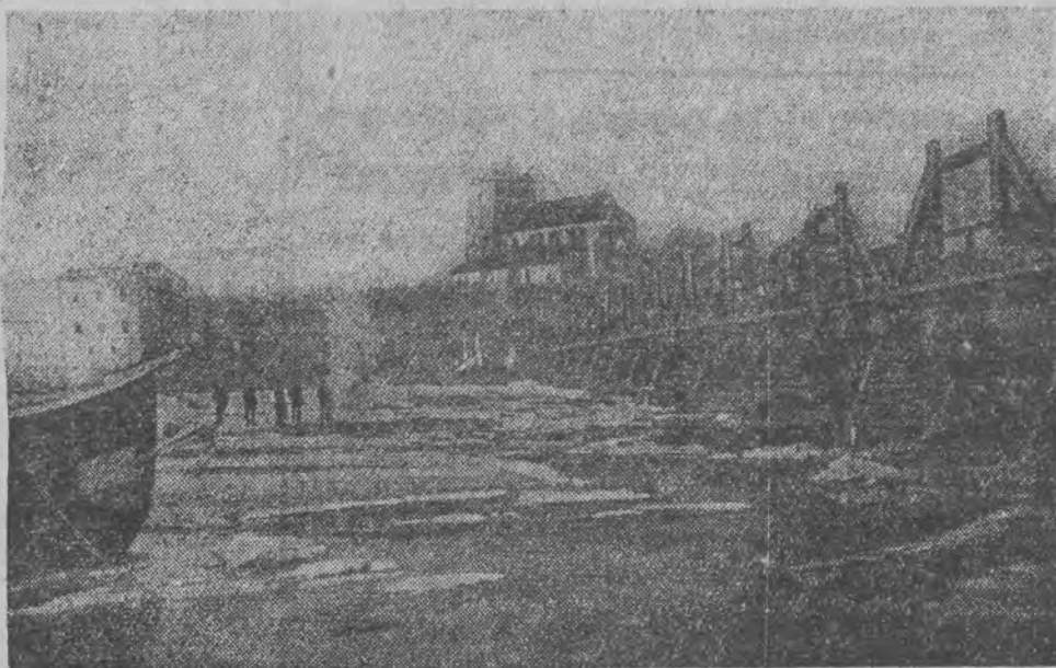
Zdjęcie nasze przedstawia rozszadanie łodów na Warcie pod m. Pyzdrami w Ziemi Kaliskiej, przeprowadzone pod kierunkiem M. Romanna i St. Stawickiego. W głębi widać mury starego zamku.
