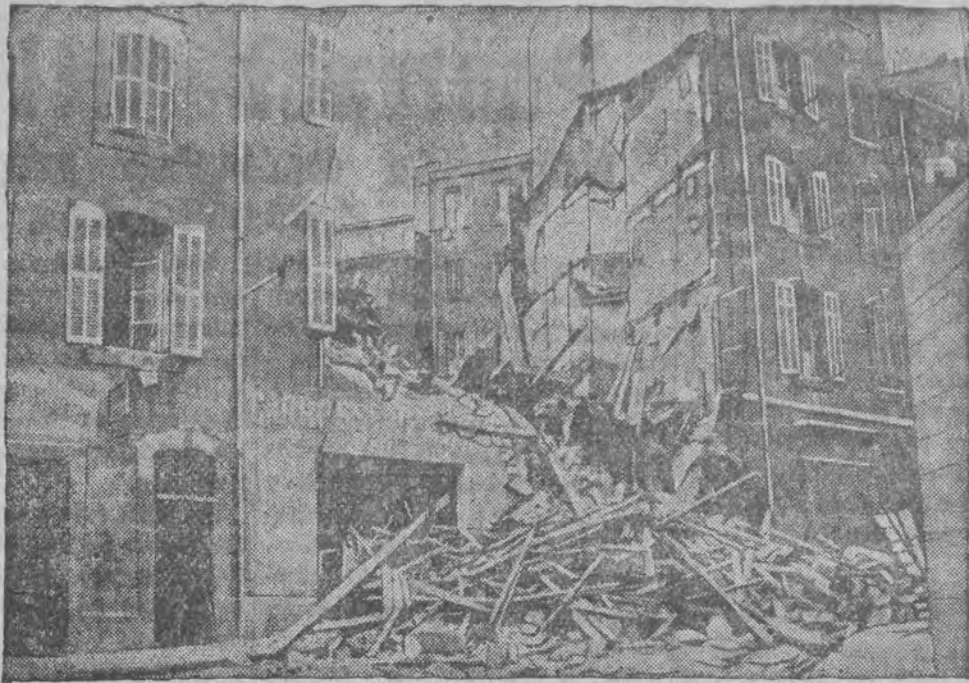
który nastąpił w domu prawdopodobnie wskutek ulatniania się gazu, spowodował całkowitą ruinę budynku. Ofiarą katastrofy padło 3 zabitych i wielu rannych.
