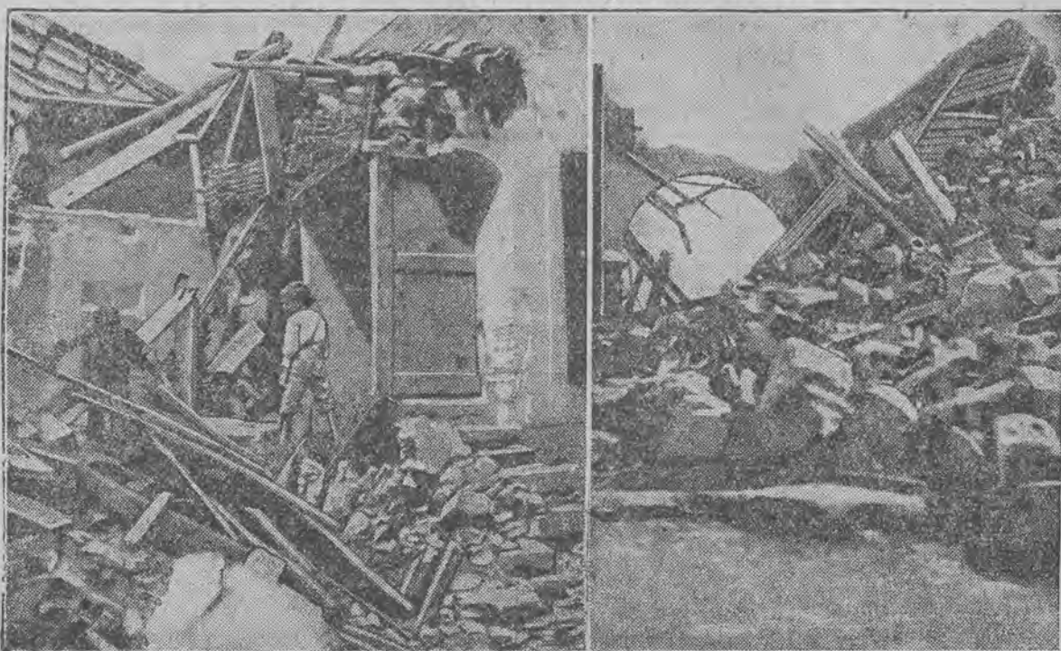
Ruiny zawalonych domów w Melfi, gdzie zapadło się 90 procent budynków, a połowa mieszkańców zginęła pod gruzami.
