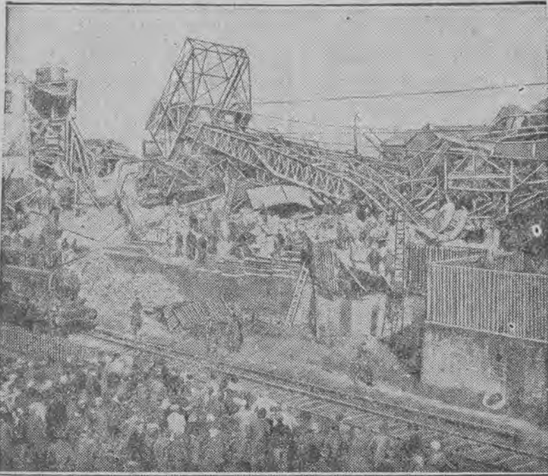
Ruiny i zwaliska z przewróconą wieżą komunikacyjną.
