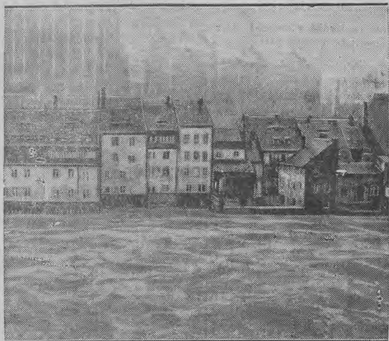
Stan wody w niektórych okolicach (na naszej ilustracji okolica Gorlic) doszedł do wysokości, nienotowanej od 27 lat
