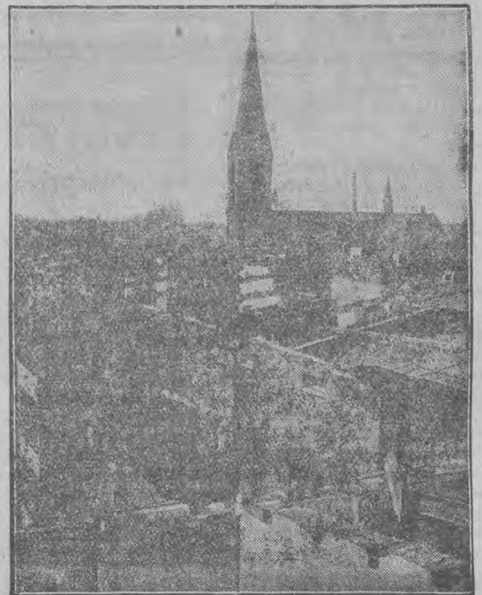
spowodowała olbrzymie straty. Na ilustracji szereg domów z zerwanymi dachami
