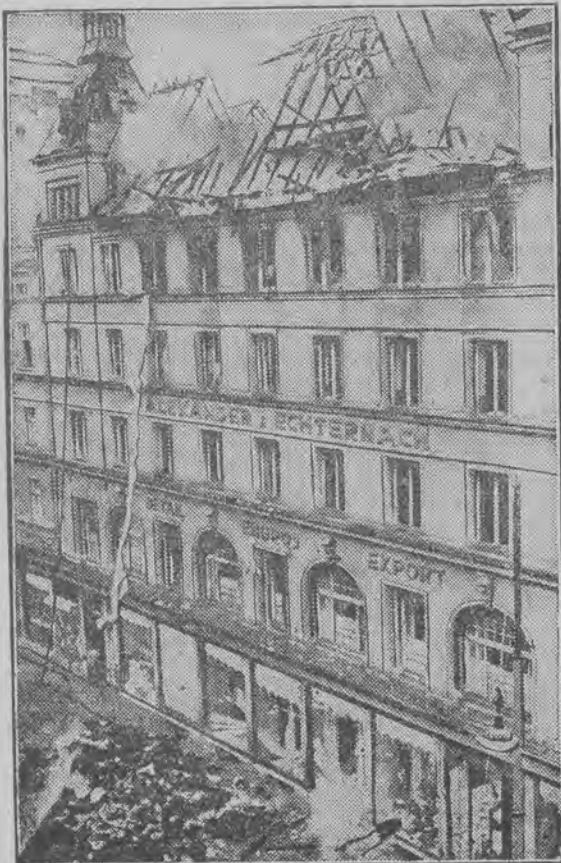
zniszczył doszczętnie poddasze i 4 piętro wielkiego domu towarowego
