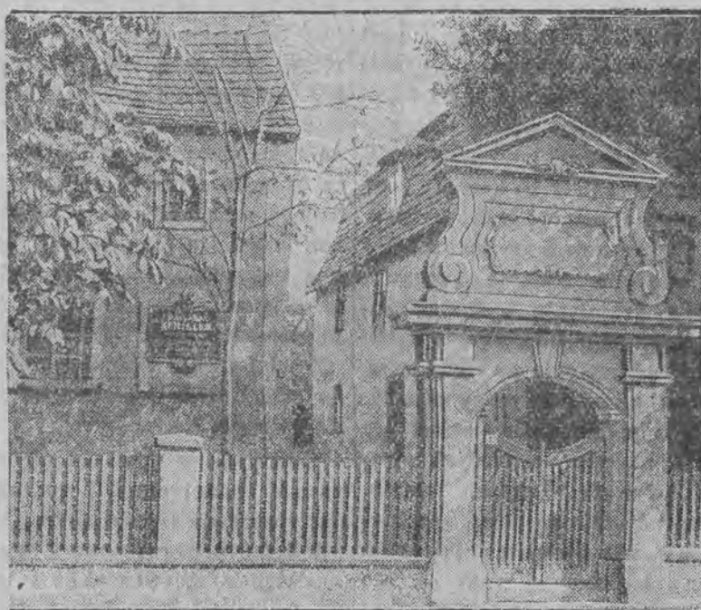
w którym wielki poeta mieszkał w roku 1785, został obecnie rozebrany, ponieważ groził zawaleniem.
