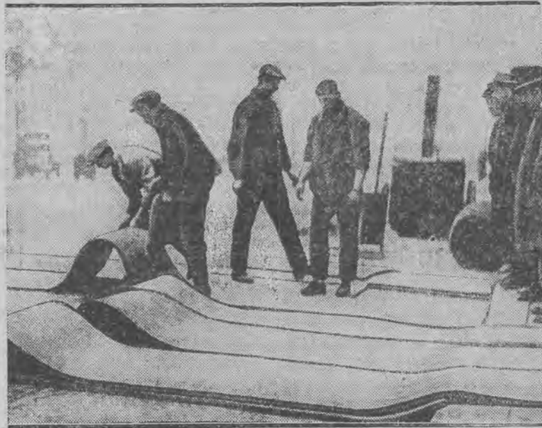
składa się z chodników gumowych, spawanych smołą.
