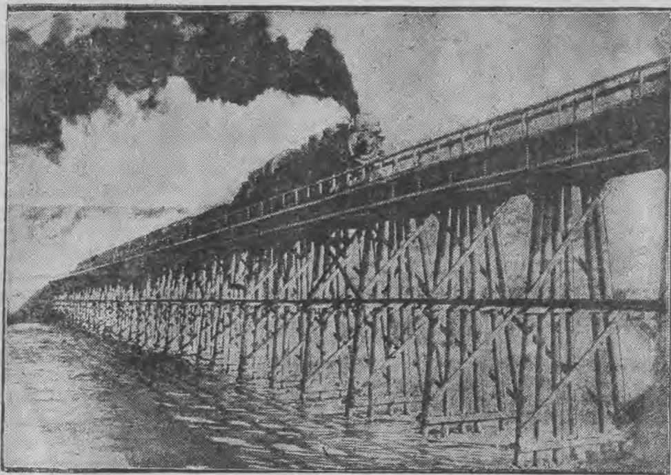
W stanie Arizona (północna Ameryka) już od miesiąca pracują na trzy zmiany przy wykończeniu tamy Hoovera. Na naszej ilustracji widzimy prowizoryczne mosty przez rzekę, które dają wyobrażenie o wielkości budowanej tamy.
