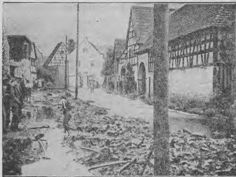
Rwący potok podmył i zniszczył główną ulicę w miasteczku Trebnitz.
