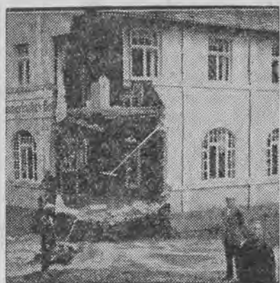
Zajazd w miasteczku Stadtra da w Turyngji został do tego stopnia podmyty podczas wylewu rzeki, że narożnik domu uległ zupełnemu zniszczeniu.
