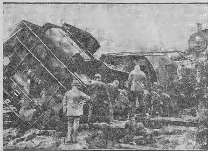
Podmyty tor kolejowy spowodował wykoślenie się pociągu towarowego pod Hermsdorfem.
