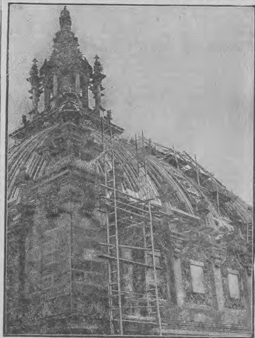
Naprawa zniszczonej kopuły gmachu parlamentu Rzeszy
