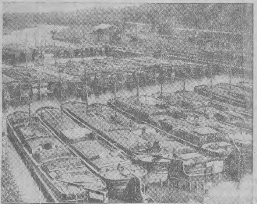
Zatory barykadowe strejkujących robotników kanałowych na rzece Oise.
