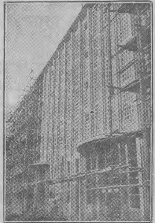
Gmach filii paryskiej Biblioteki Narodowej, wybudowany z żelazobetonu i szkła.
