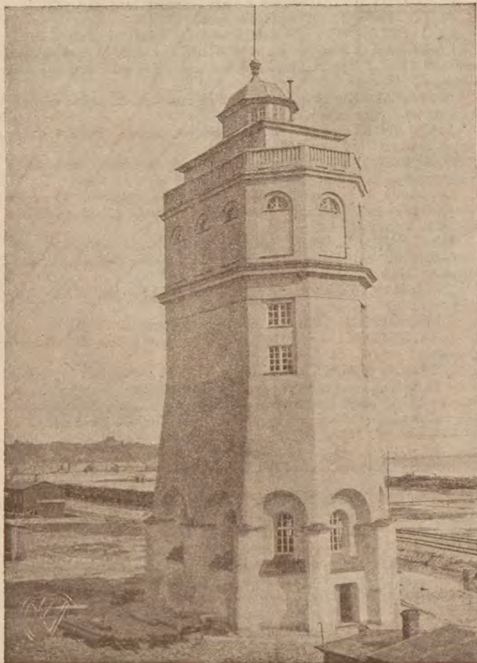
Fot. Marcinkowski Wieża wodociągowa w Gdyni zaopatrująca statki w wodę do picia i do maszyn.
