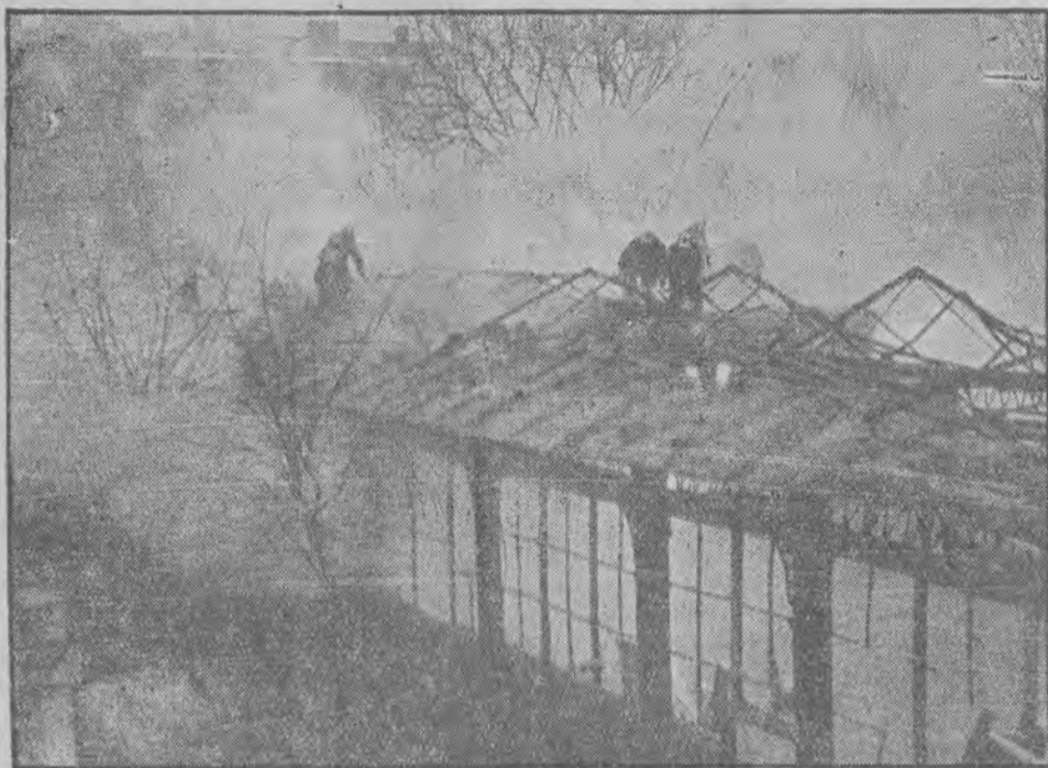
PRZESZŁO 100 TYS. ZŁ WYNOSZĄ STRATY. spowodowane wczorajszym pożarem kinoteatru „Gloria“ w Warszawie. Kino spłonęło doszczętnie z całym urządzeniem aparatami i trzema taśmami długometrowych filmów. — Na obrazu: fragment akcji ratunkowej, prowadzonej przez strażaków. — Fot. Jajkowski — Warszawa.
