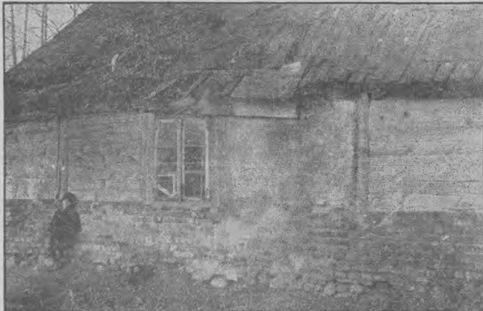
Dom w którym zamieszkuje bezrobotny Świrka w Turku. W dachu widać dziurę, przez którą w czasie deszczu woda ścieka do mieszkania. Pod murem stoi pięcioletni syn Świrka.
