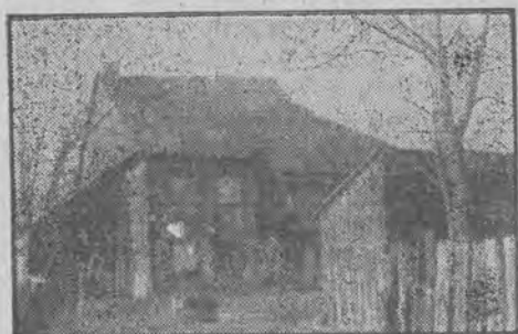
Dom przy ul. Dobrskiej 39, gdzie zamieszkuje drugi bezrobotny Antoni Krysiak z rodziną, żyjącą w okropnych warunkach materialnych. Krzyżki na oknach wskazują na miejsca zasłonięte papierem zamiast szyb.
