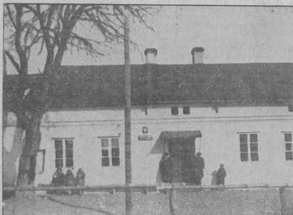
Budynek kminy Wolborz, do której przygodnie zabłądził żołnierz niemiecki, kryjący się przed kozakami i gdzie później aresztowani zostali wójt Jan Miksa, sekretarz wójtostwa Antoni Ogrodziński i Mieczysław Smółka. Aresztowanych oskarżono o wydanie żołnierza Moskalom i skazano na śmierć.
