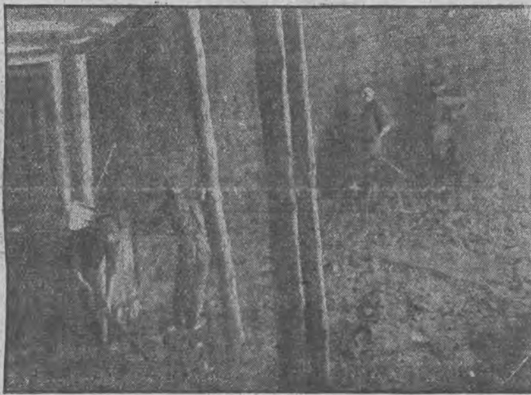
Pożar na kopalni „Reden“ w Dąbrowie tłumni się obecnie drogą, t. zw. kneblowania szybów. Na rycinie: jeden z chodników kopalni „Reden“.
