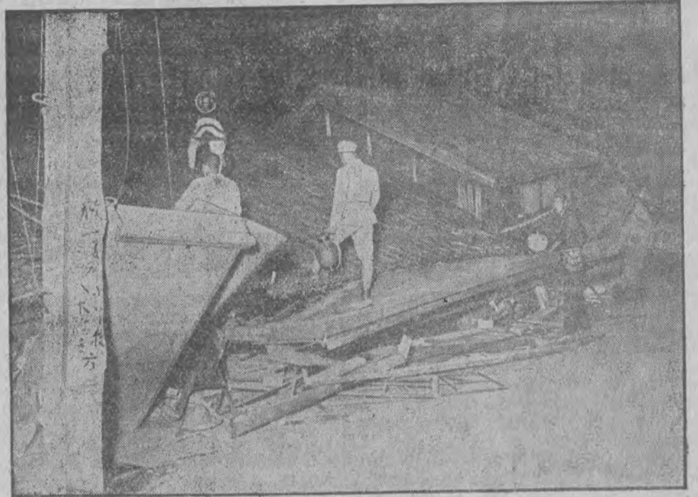
Trzęsienie ziemi w Japonii jest rzeczą dość zwykłą. Oto obrazek z ostatniej katastrofy w Shizuoki, gdzie zniszczonych zostało wiele domów i zginęło kilkanaście osób. Domy mieszkalne zapadły jakby w ziemię. Ulica pokryta jest stosami kamieni, belek i rozbitych szyb.
