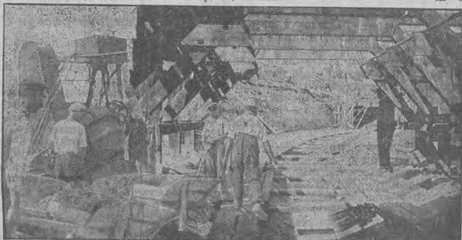
Prace przy uregulowaniu Łódki: z lewej betoniarnia, z prawej roboty przy kanale.
