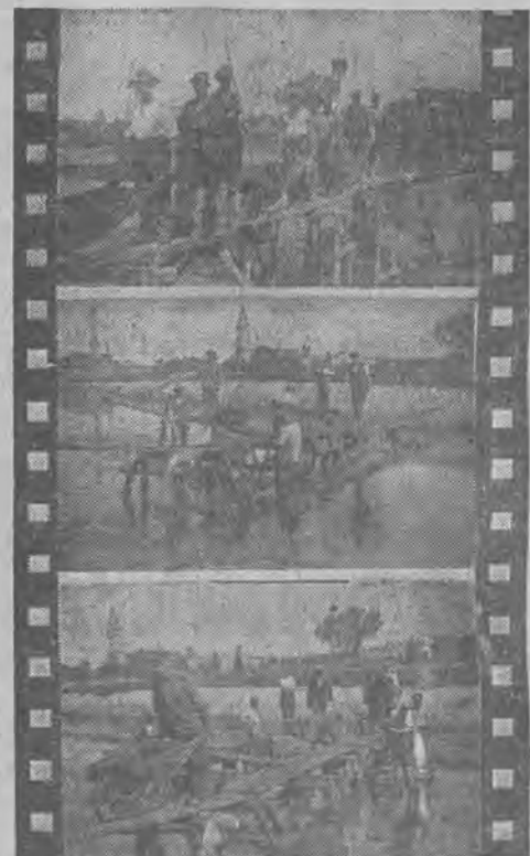
Robotnicy pabjanicki na robotach publicznych. Od góry: robotnicy udają się do pracy specjalną kładką, na drugą stronę rzeki; przesuwanie rusztowania na drugi brzeg; robotnicy podczas wydobycia szlamu i wywożenia go po wąskich kładkach.
