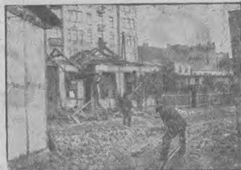
Niedawno przystąpiono do pierwszego aktu wydalania kolejek dojazdowych poza obręb śródmieścia Warszawy, mianowicie do rozbiórki dworca kolejki Grójeckiej i jego urządzeń. Na zdjęciu dworzec w czasie rozbiórki. Fot. K. Jajkowski — Warszawa
