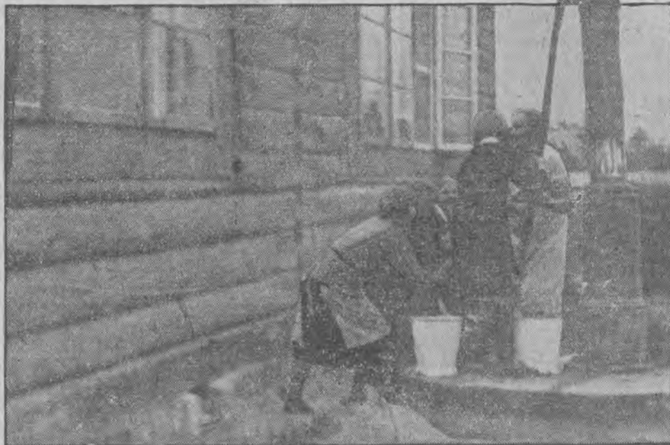
Tam, gdzie mieszkają robotnicy łódzcy. Na prawo „gimnastyka” przy pompie.
