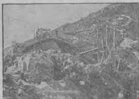
Kamieniołomy i budowa wież dla kolejki, pod szczytem Kasprowego Wierchu.
