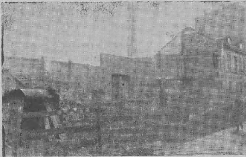
Dom przy ul. Solnej 11. róg ul. Północnej w Łodzi, który groził zawaleniem się, obecnie poddany został rozbiórce.
