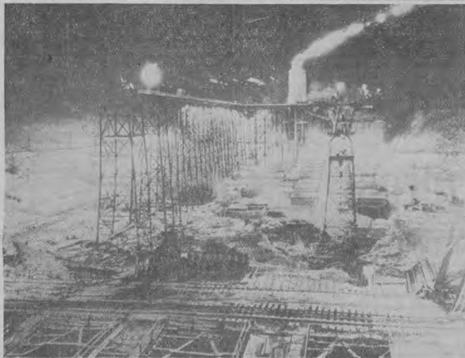
W Seattle, w stanie waszyngtońskim (Stany Zjednoczone) buduje się olbrzymią tamę oraz elektrownię. Teren budowy, na którym pracuje się bez przerwy przez 24 godziny, jest nocą oświetlony setkami reflektorów.
