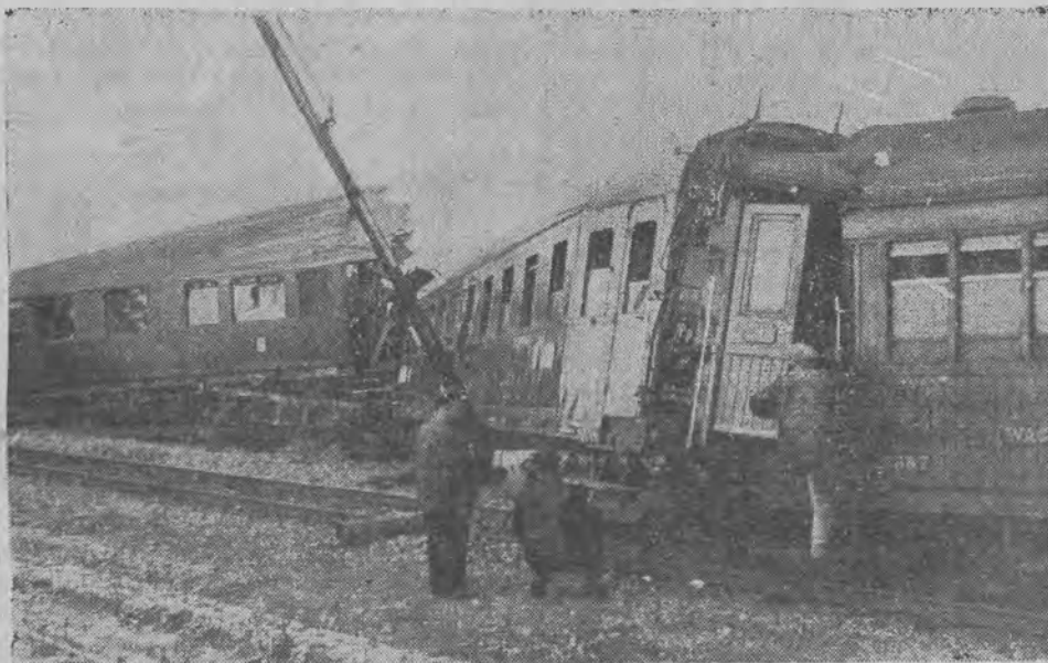
Widok na spiętrzone i strzaskane wagony pullmanowskie. Na prawo widoczna część wagonu restauracyjnego, w którym, w chwili wypadku, znajdowało się 30 osób przy obiedzie. Wskutek zderzenia stoły restauracyjne zostały wyrwane z podłogi.
