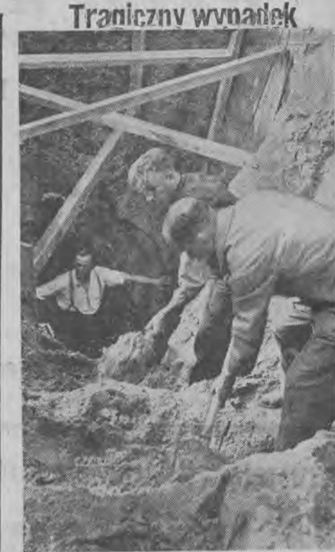
Poznań, 11. 8. — Na Ławicy pod Poznaniem uległ zasypaniu ziemią przy pracy studniarz Stanisław Tomaszewski. Mimo 7-godzinnej wyjęzonej pracy, Tomaszewskiego nie zdołano do wieczora wydobyć. Na zdjęciu prace nad wydobywaniem nieszczęśliwego. (Foto-Express Majewski — Poznań)
