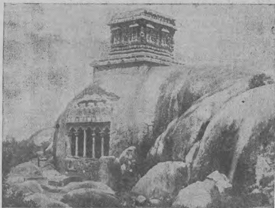
Niezwykłą osobliwością jest świątynia indyjska w Yemapuran, znajdująca się w odległości 60 km. od miejscowości Madras nad morzem. Świątynia ta wykuta w skale jest wzorem architektury staroindyjskiej.
