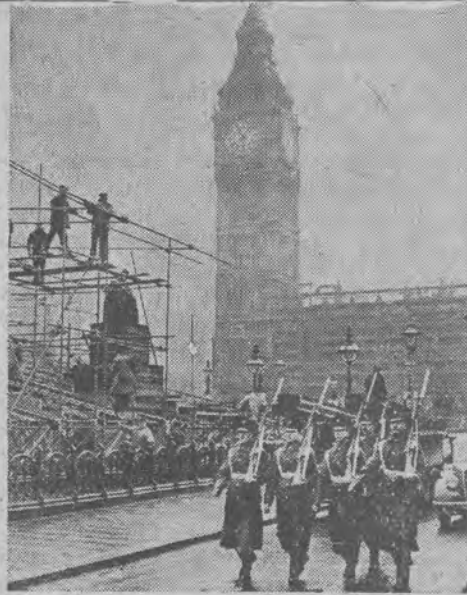
Koronacja króla Jerzego VI zbliża się już. W Londynie buduje się trybuny dla ciekawych. Na zdjęciu widzimy budowę rusztowania pod trybuny na Parliament Square.
