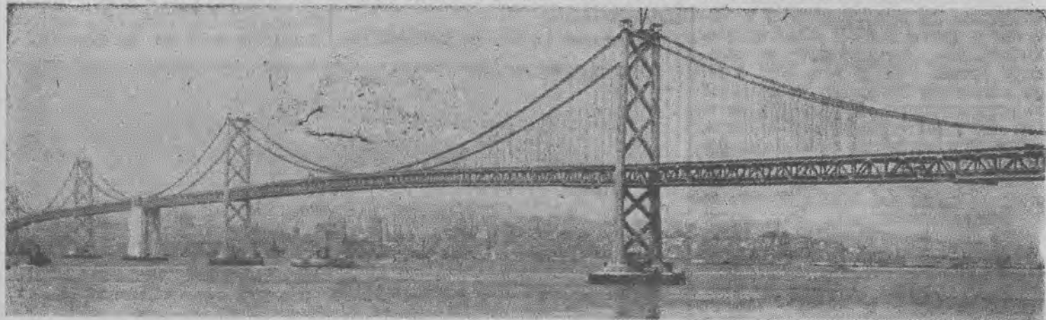
Most wiszący łączący San Francisco z Oaklandem poprzez zatokę San Francisco. Jest to najdłuższa konstrukcja mostowa na świecie o całkowitej długości 13,5 km. Największa rozpiętość przęsła wynosi tylko 900 m.
