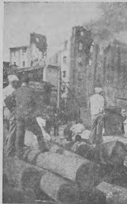
Srożący się żywioł we wnętrzu czteropiętrowego gmachu.
