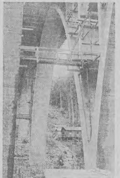
Pod Ettingen w pobliżu Stuttgartu buduje się olbrzymi wiadukt o długości 360 m, przechodzący 40 m ponad dolina. Wiadukt połączy dwa odcinki wybudowanej już autostrady.
