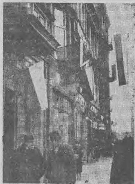
Do ogólnego nastroju żałoby społeczeństwa poznańskiego dostosowano wygląd miasta. Ze wszystkich domów, balkonów i okien zwisają flagi żałobne
