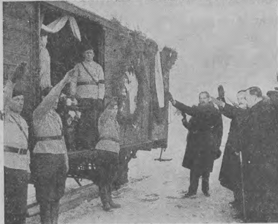
WAGON, W KTÓRYM PRZEWIEZIONO ZWŁOKI ROMANA DMOWSKIEGO Z ŁOMŻY DO WARSZAWY
