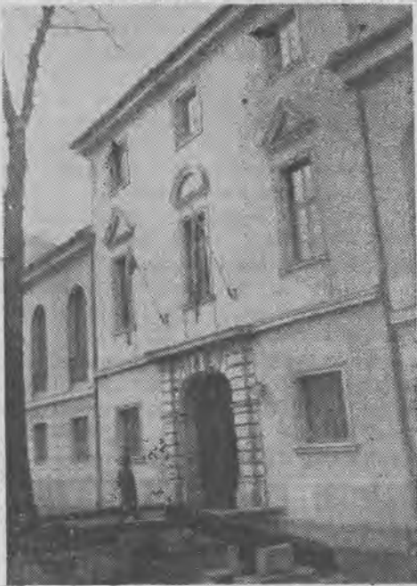
Brama Arsenatu od ul. Długiej
