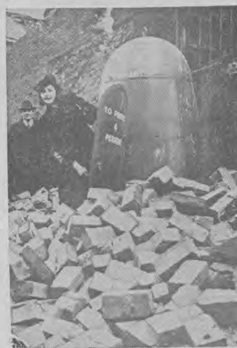
Schron z siatki żelaznej dla 4 osób. Przygnieciony gruzami starej fabryki, wysadzonej w powietrze, wytrzymał próbę, a młode dziewczę, które się w nim „schroniło”, nie poniosło szkody
