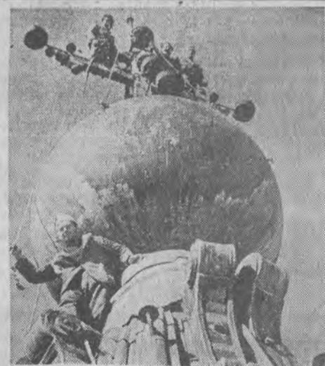
Na wieży Bazyliki św. Piotra w Rzymie na wysokości 133 metrów zainstalowano urządzenia świetlne. Prace robotników wymagały niemałej zręczności i akrobacji.
