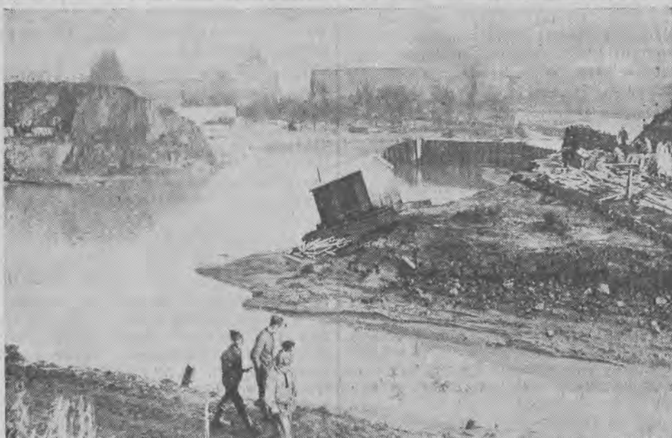
WEZBRANE WODY PRZERWAŁY TAMĘ
