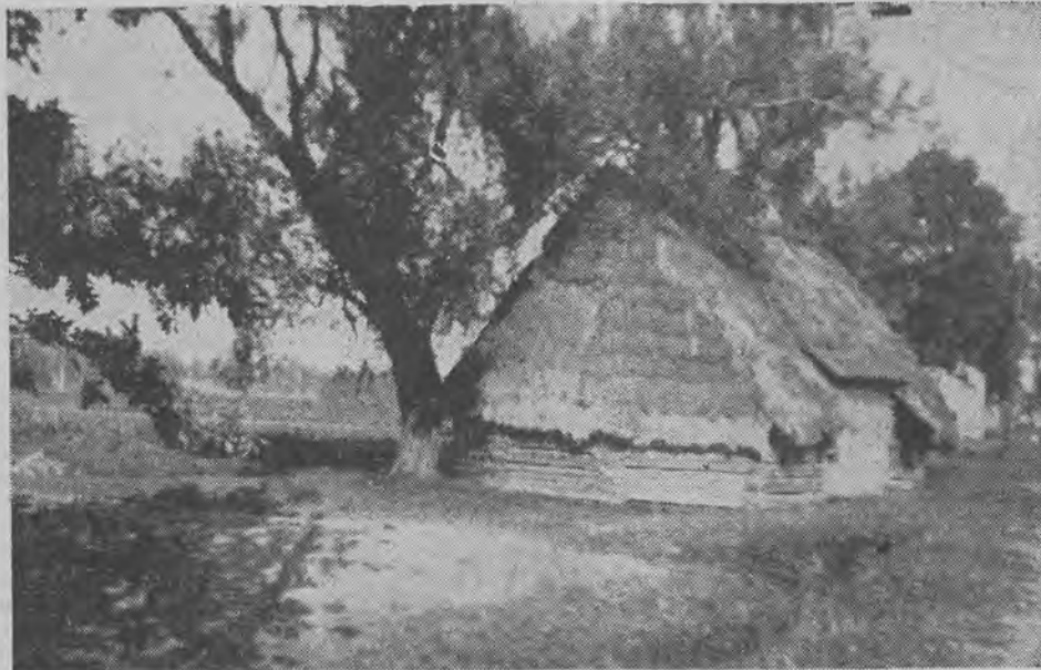
Stodola w Strumieniu. Uwagę zwraca zanikający już sposób budowy stodoł — w ośmiobok
