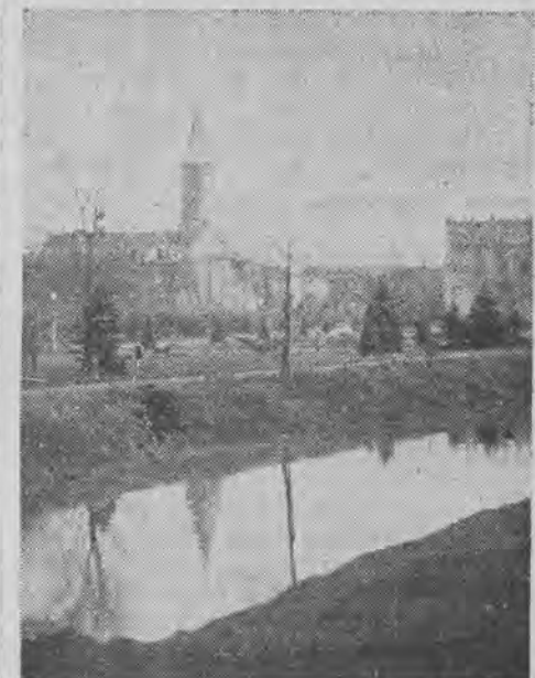
Zdale widać kontury starożytnego kościoła
