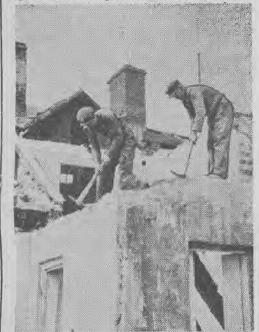
Rozbiórka robotniczego domku
