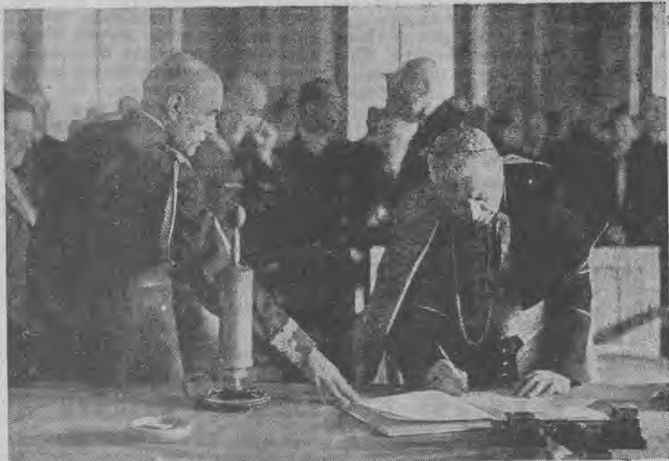
J. E. ks. Prymas Hlond podpisuje odezwę Komitetu Pożyczki Obrony Przeciwlotniczej, obok gen. Berbecki.
